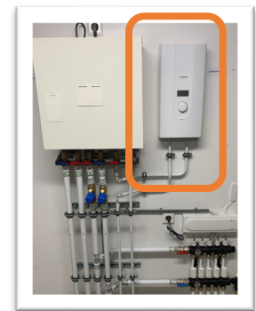
Afbeelding 1 Afleverset inclusief verdeler, wisselaar, GJ-meter en doorstroomapparaat
